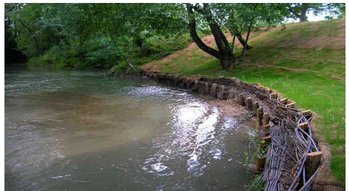
Séoune : stabilisation de berges par technique végétale douce
