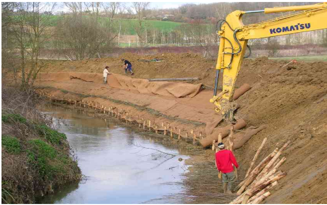
Tolzac : restauration de la berge
